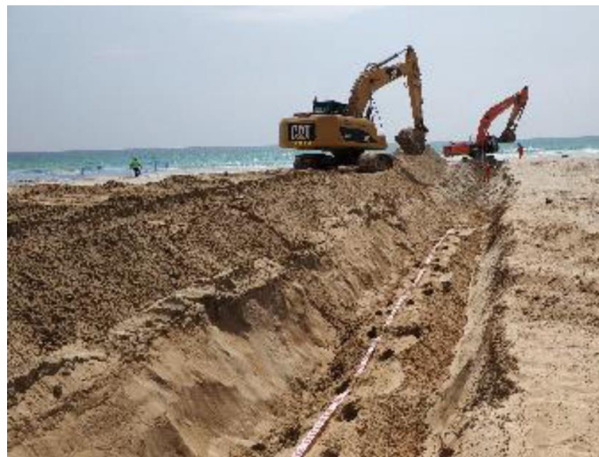
Figure 14 : Photo de la tranchée de raccordement de la « sea plate » à la chambre d'atterrage
