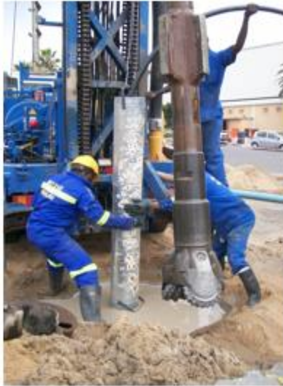
Figure 15 : Opération de forage dans le cadre de l'installation d'électrodes (Source : Orange)
