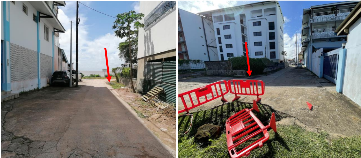
Figure 23 : Impasse dans laquelle est localisée la chambre d'atterrage (flèche rouge), vue vers le nord à gauche et vue vers le sud à droite (source : Orange)
