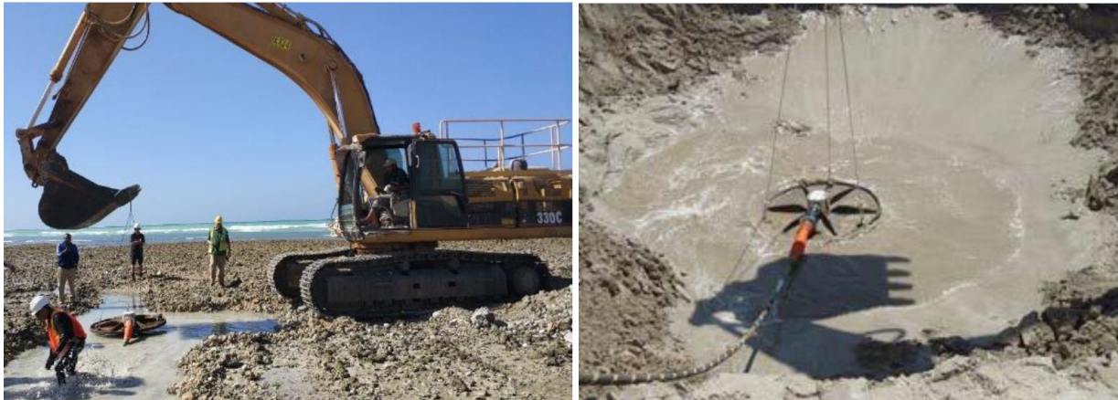
Figure 13 : Photo de travaux d'excavation préparant l'installation de la sea plate à gauche et implantation de la sea plate à droite
