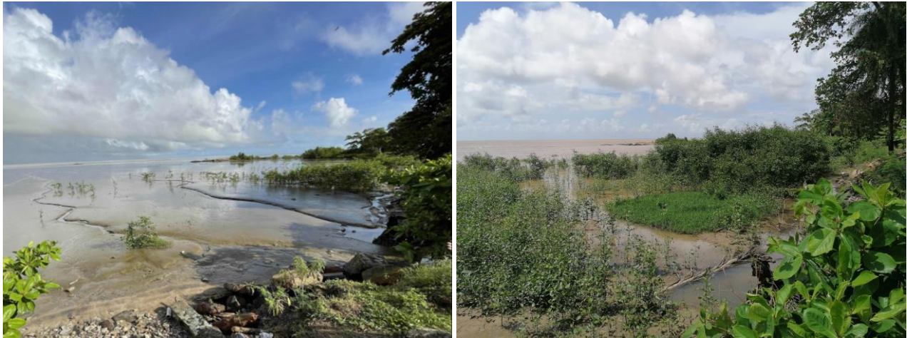
Figure 31: Site d'atterrage de l'Anse Méret (vue vers l'est) photographié en décembre 2021 à gauche et en avril 2022 à droite (Sources : Orange et setec)
