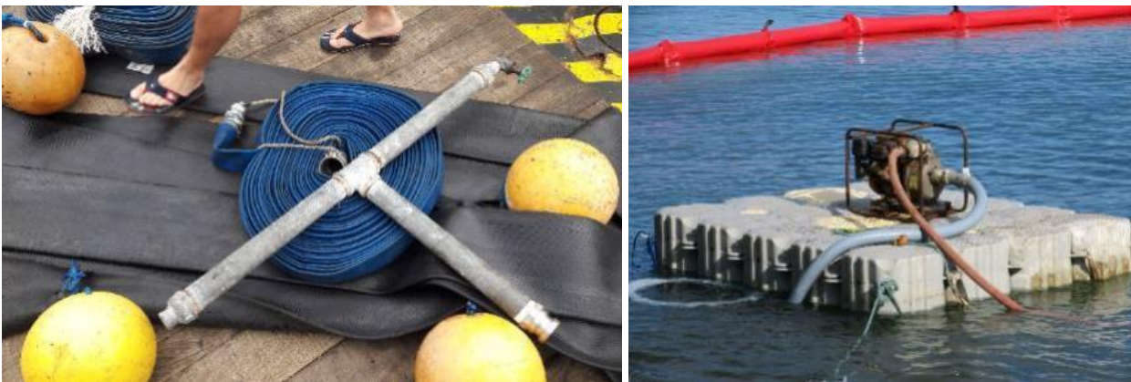
Figure 40 : Ensouillage avec lance à eau opérée par plongeur et motopompe installée en surface (Source : Orange Marine)
