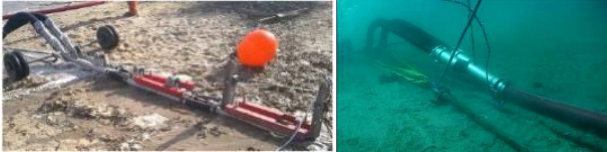
Figure 39 : Ensouillage par jetting avec outil tracté de type « Worm » sur navire petit fond (Source : Orange Marine)
