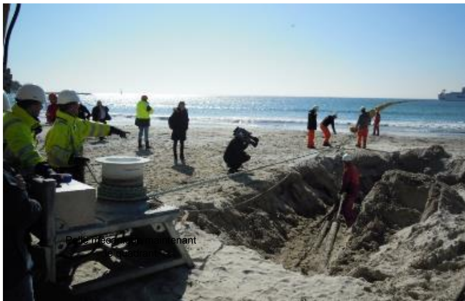
Figure 28: Opération de tirage du câble à terre avec un cabestan hydraulique (source : Orange marine)
