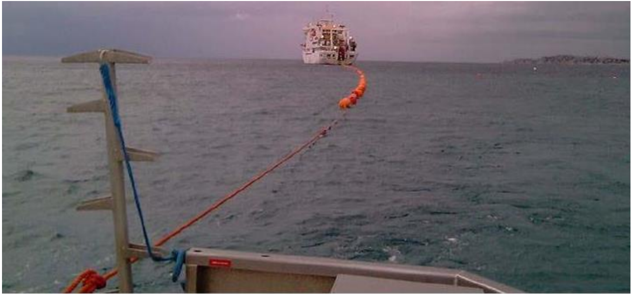
Figure 36 : Exemple d'un câble tiré depuis un navire câblé vers la plage via des bouées flottantes (Source : Orange Marine)
